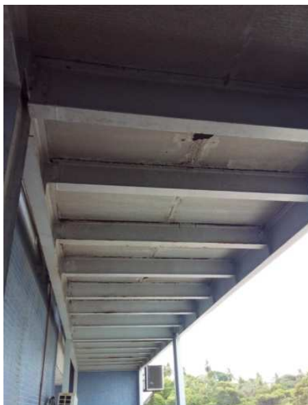
Figura 02 – Estrutura metálica da Laje do Mezanino
