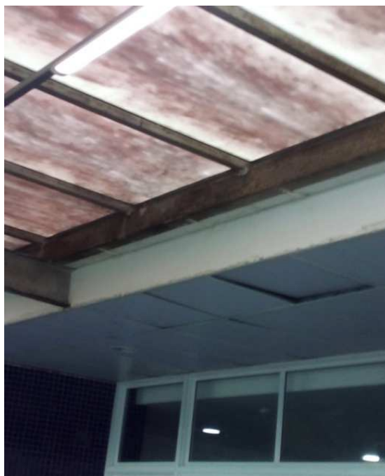
Figura 07 – Vigas da cobertura do acesso principal
