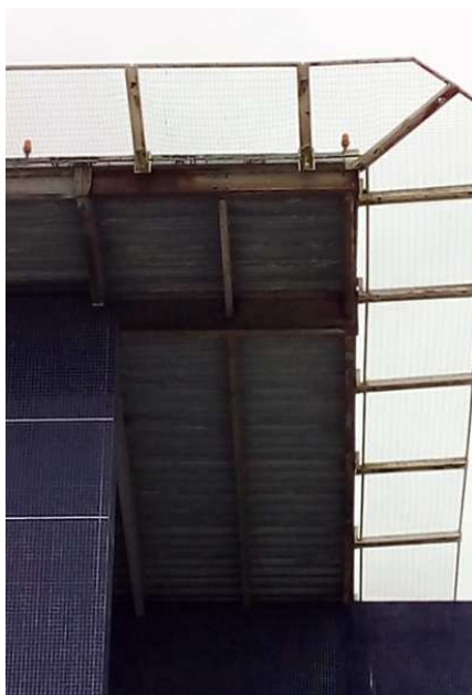
Figura 01 – Vigas e estruturas da laje do Heliponto
