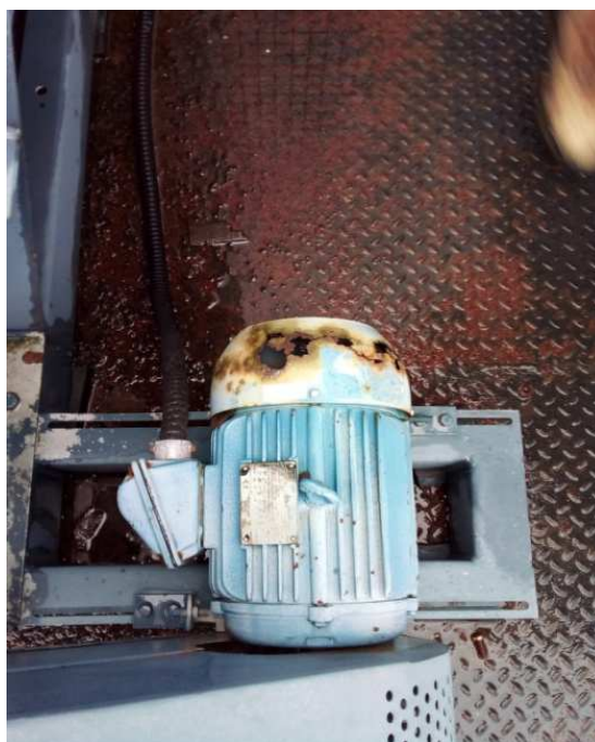
Figura 08 – Laje dos Exaustores em chapa de aço
