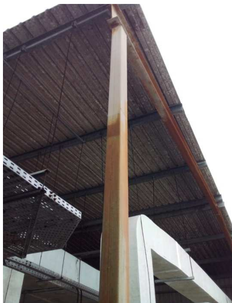
Figura 03 – Pilares e vigas da Central de Ar-condicionado
