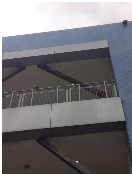
Figura 06 – Estruturas na fachada do forro lateral
