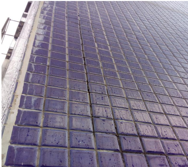
Figura 03 – Revisão de Rejuntamento das Fachadas
