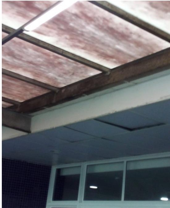
**Figura 08 – Laje dos Exaustores em chapa de aço**
