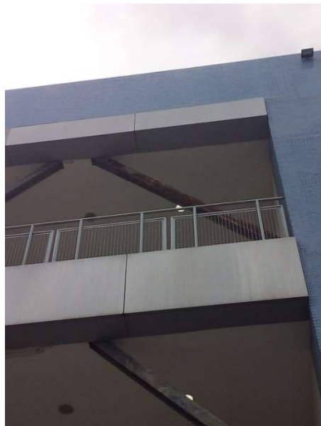
Figura 06 – Estruturas na fachada do forro lateral
