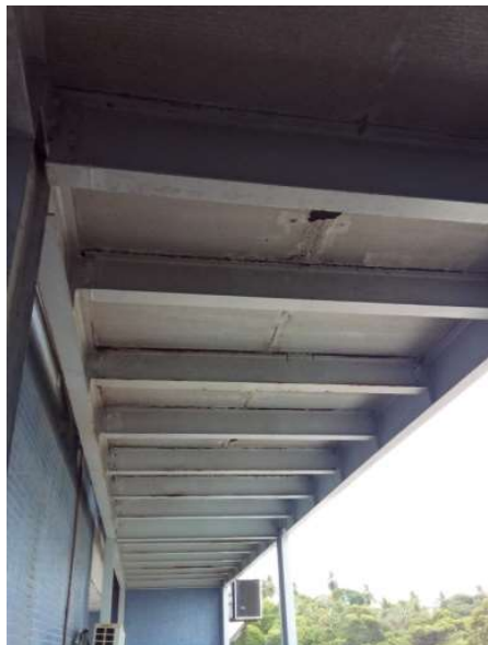
Figura 02 – Estrutura metálica da Laje do Mezanino
