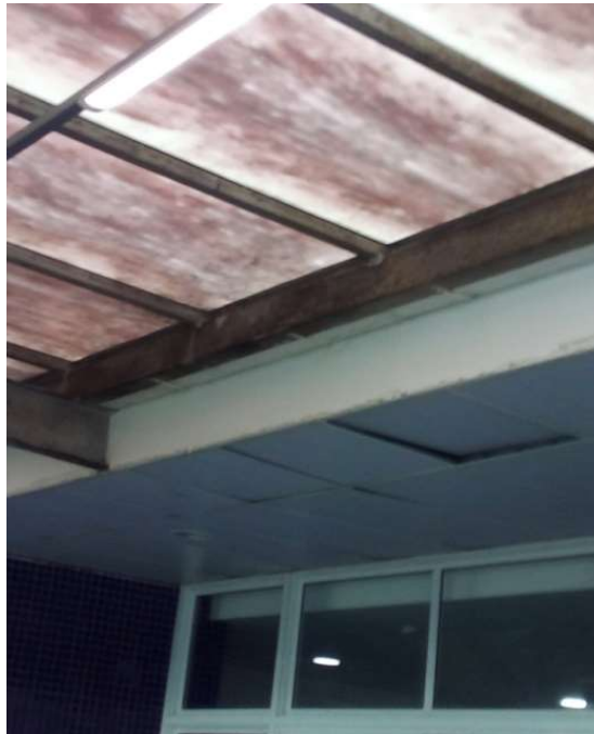
Figura 07 – Vigas da cobertura do acesso principal
