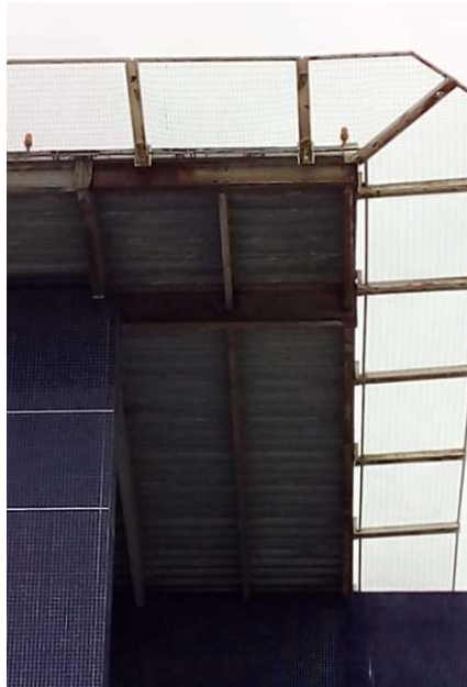
Figura 01 – Vigas e estruturas da laje do Heliponto
