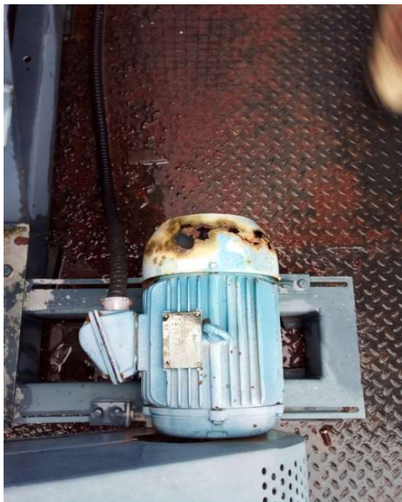
Figura 08 – Laje dos Exaustores em chapa de aço
